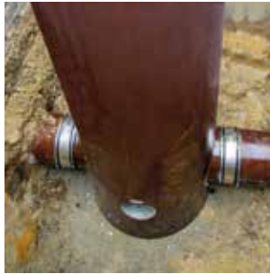
Setzen des Schachtes
