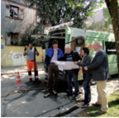
Bild 7: Arbeitsgespräch auf der Baustelle, speziell zur Planung und Ausführung der Wasserhaltungen.
