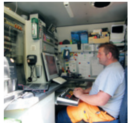
Bild 5: TV-kontrolliertes Arbeiten im Kanal.
