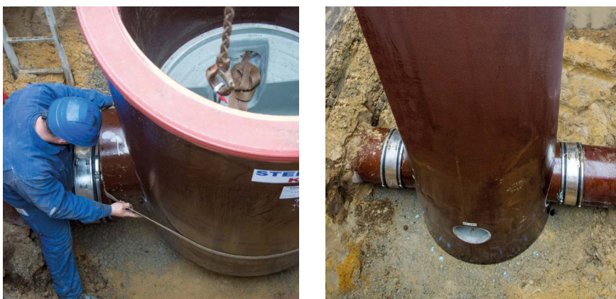
Posa dei pozzetti
