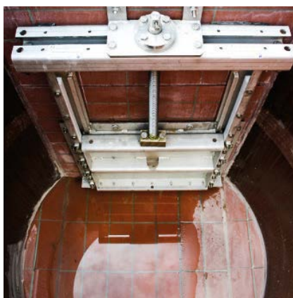
Instalación de corredera de placa
