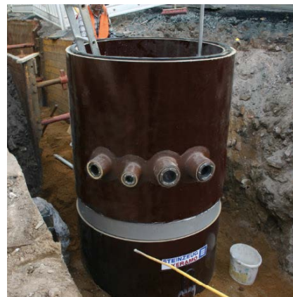
Pozo especial con conexiones para líneas de presión en la sección superior
