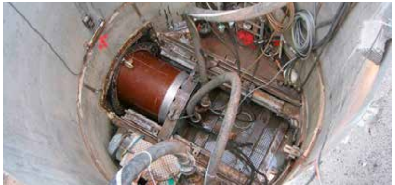
Stahlbetonabsenkschacht mit Unterteil und Aufsatzteil
