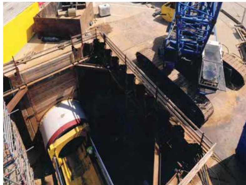
Kombinierte Baugrube aus Spundwand und Trägerbohlwand
