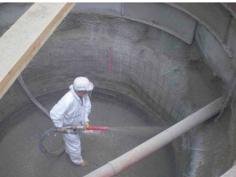
Spritzbetoneinbau
