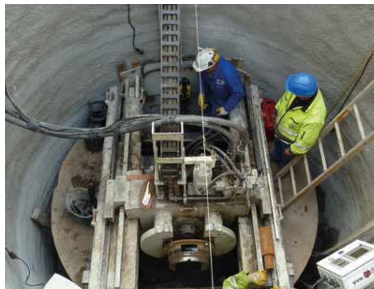
Baugrube mit Spritzbetonsicherung
