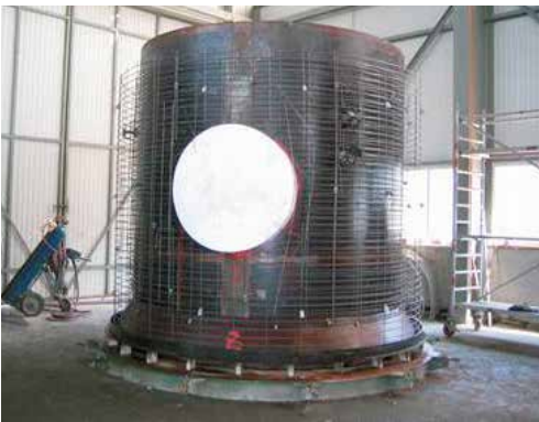
Unterteil Absenkschacht mit Bewehrung und Durchfahrtsöffnung
