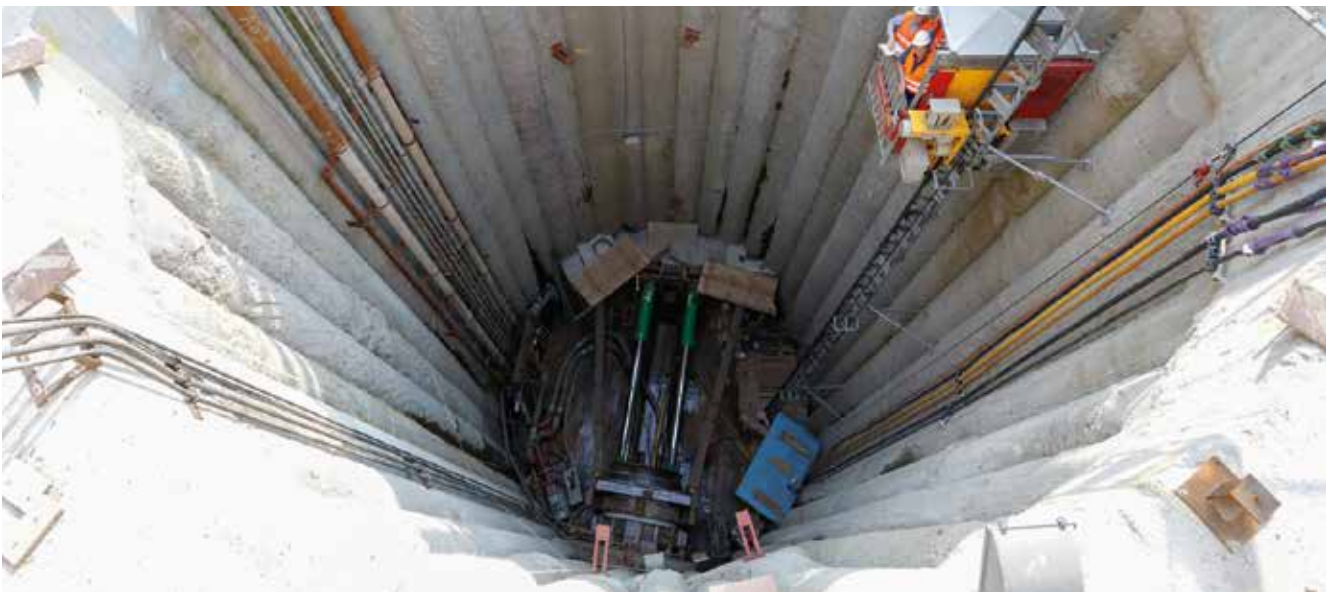
Baugrube mit Bohrpfahlsicherung
