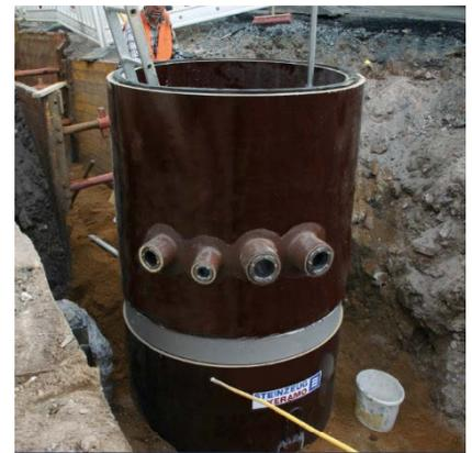
Sonderschacht mit Anschlüssen für Druckleitungen im Aufsatzstück
