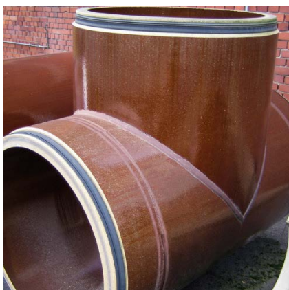
Studnia na głównym kolektorze
