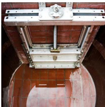
Montaż zasuwki płytowej
