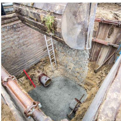
Przygotowanie podłoża
