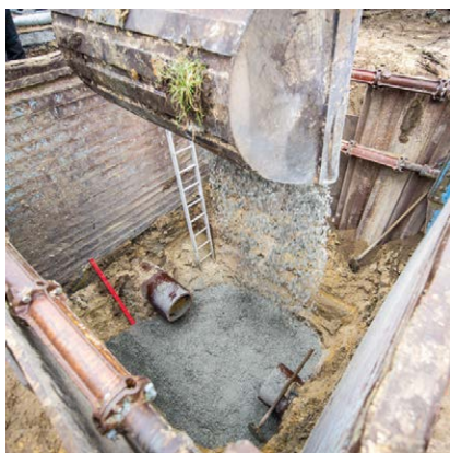
Executarea unui strat suport corespunzător
