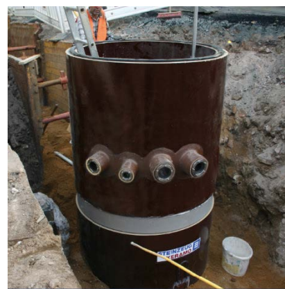
Căminul de vizitare special cu racorduri pentru conductele de presiune în segmentul superior
