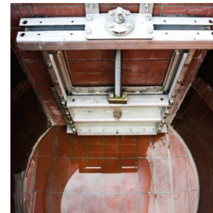
Pose d'une vanne à guillotine
